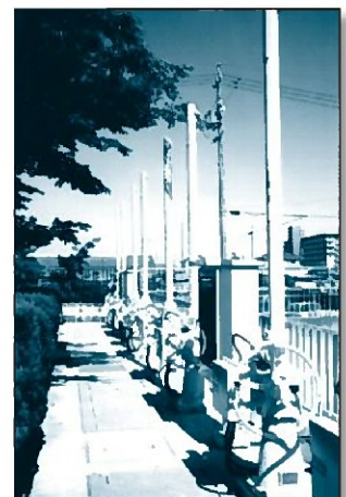
1000W×2500H 角形外ねじ式ゲート 電動開閉台据付完了
